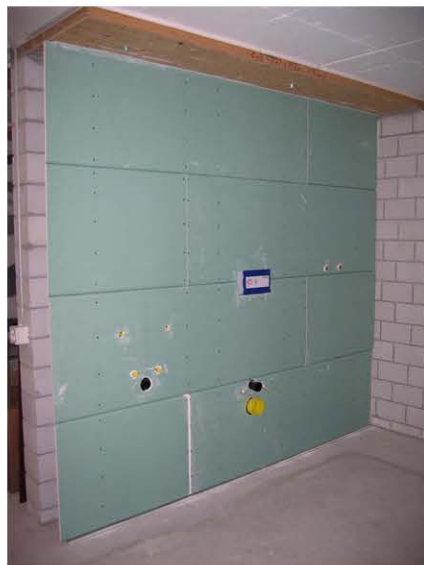
Afbeelding 207: Ruimtehoge Duofix voorwandinstallatie
